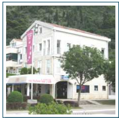
GEWERBEFLÄCHE »BUDVA GATES« Budva
